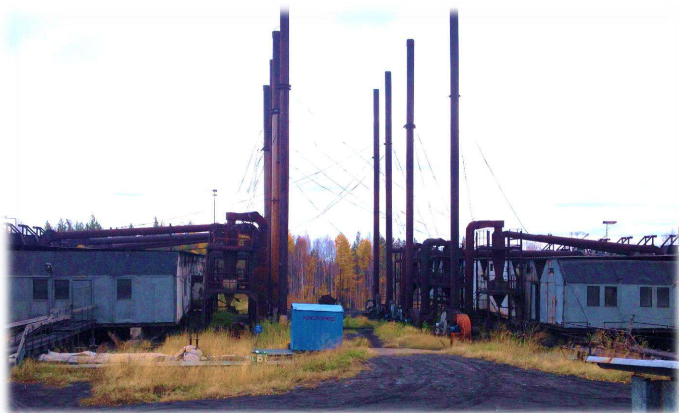
Рисунок 3 Комплекс котельных Алгатуйского сельского поселения.
