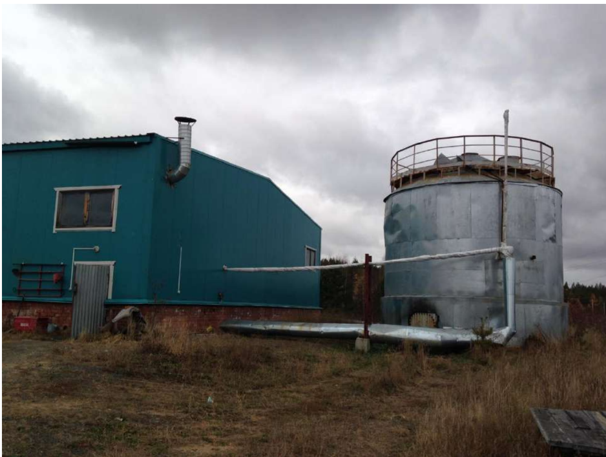
Рис. 8. Канализационные очистные сооружения. Внешний вид.
